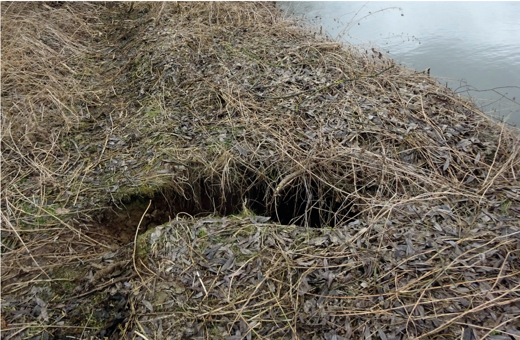
Chodníky bobrů narušují břehy rybníků a mohou způsobit propojení rybníka s obtokovou stokou. Foto Jitka Uhlíková
