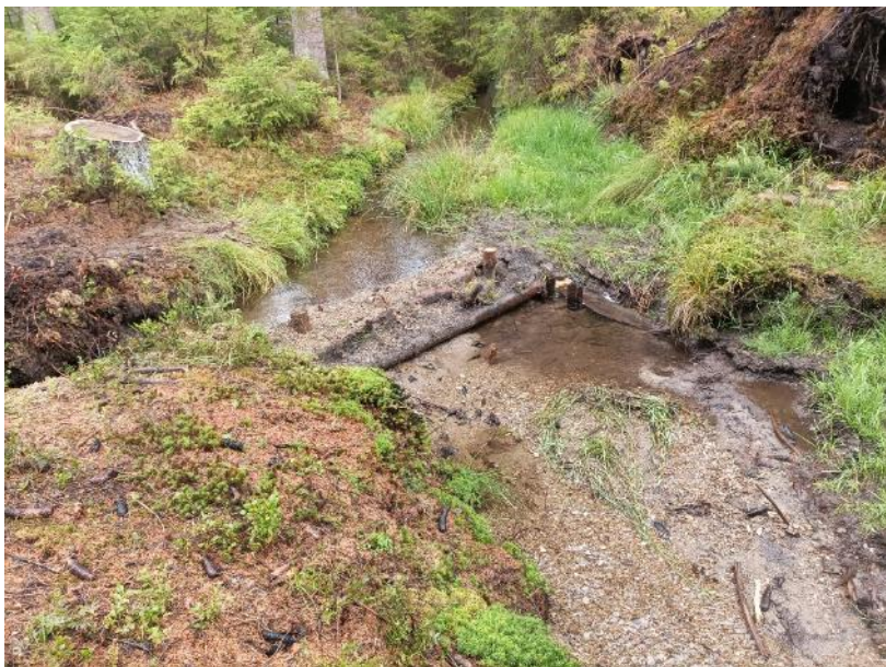
Obr. 6: Rybníček u Starých Hutí: obnovený náhon do rybníčka. Foto J. Skála, 1. srpna 2023
