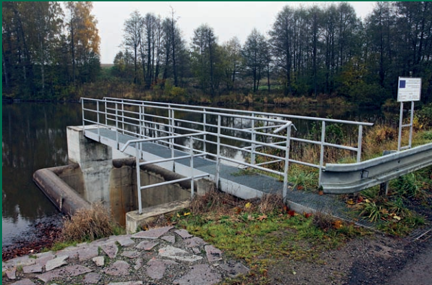
1. Nevhodné řešení. Tzv. sdružený bezpečnostní objekt vytváří ve většině případů pro vydra nepřekonatelnou bariéru.
