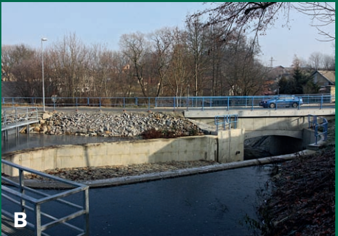
2. Nevhodné řešení. I když samotný průchod mostkem pod silnicí (obr. B) je v tomto případě pro vydra bezproblémový, bezpečnostní přepad s vysokou přelivnou hranou znamená pro vydra nepřekonatelnou bariéru. Zde navíc vytvářejí bariéru kromě vysokého přelivu také kovové česle oddělující bezpečnostní přepad od zbytku rybníka (obr. A).
