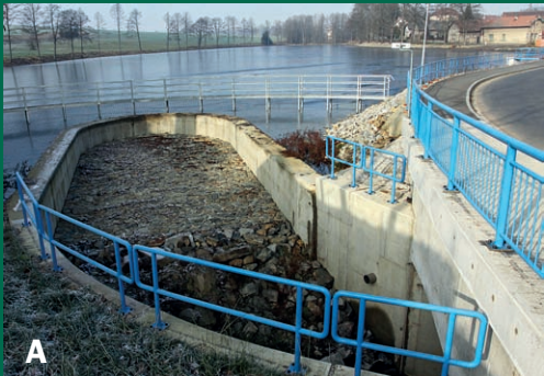
2. Nevhodné řešení. I když samotný průchod mostkem pod silnicí (obr. B) je v tomto případě pro vydra bezproblémový, bezpečnostní přepad s vysokou přelivnou hranou znamená pro vydra nepřekonatelnou bariéru. Zde navíc vytvářejí bariéru kromě vysokého přelivu také kovové česle oddělující bezpečnostní přepad od zbytku rybníka (obr. A).
