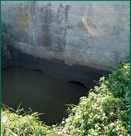
1. Nevhodné řešení. Propustky, u kterých voda přesahuje třetinu jejich průřezu, jsou pro vydra většinou neprůchodné.
