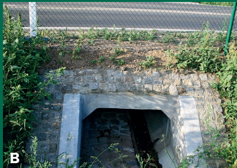
4. Vhodné řešení. Propustky s přirozeným dnem (obr. A) využívají vydry ochotněji než v případě technického dna (obr. B). Přirozené dno také umožňuje snadnější monitoring funkčnosti (viditelné stopy, v tomto případě navíc vhodně umístěný kámen vybízí vydru ke značkování).
