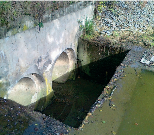
33. Detail neprůchozího přelivu rybníka Rozňák.
