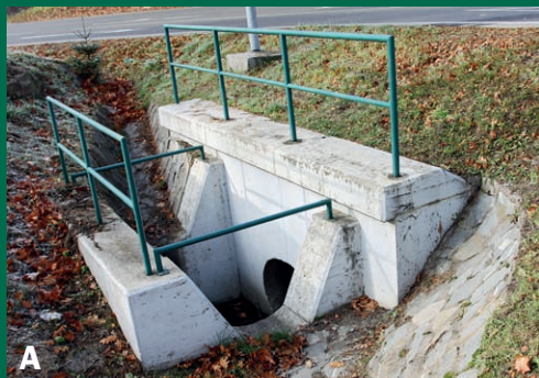
5. Nevhodné řešení. Průchodnost jinak vhodných propustků může být omezena nevhodnými technickými úpravami na vtok: sedimentační jímka (obr. A) a česle k zachycování splavenin (obr. B).
