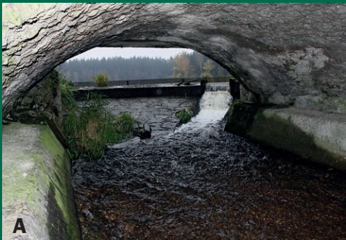
3. Vhodné řešení. Bezpečnostní přepad s výškovým stupněm do 20 cm je pro vydra průchozí
