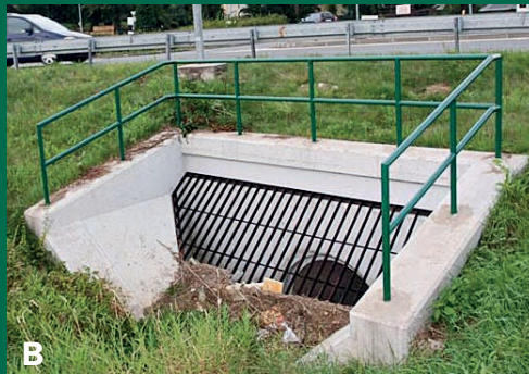
5. Nevhodné řešení. Průchodnost jinak vhodných propustků může být omezena nevhodnými technickými úpravami na vtok: sedimentační jímka (obr. A) a česle k zachycování splavenin (obr. B).
