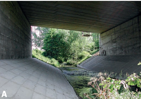
7. Průchodnost mostů pro živočichy je kromě rozměrů dána především způsobem úpravy podmostí. Vydry je sice obvykle k technickým úpravám značně tolerantní, přesto představují tyto mosty příklady nevhodného „tvrdě technického“ řešení, kdy požadavky na průchodnost pro živočichy nejsou brány v úvahu.
