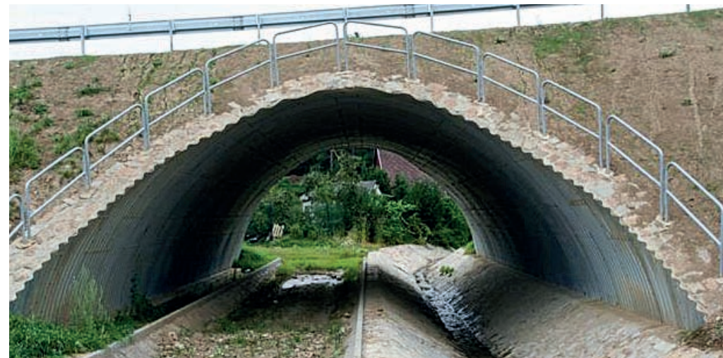
9. Konstrukce typu „Tubosider“.
