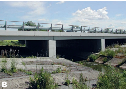
7. Průchodnost mostů pro živočichy je kromě rozměrů dána především způsobem úpravy podmostí. Vydry je sice obvykle k technickým úpravám značně tolerantní, přesto představují tyto mosty příklady nevhodného „tvrdě technického“ řešení, kdy požadavky na průchodnost pro živočichy nejsou brány v úvahu.
