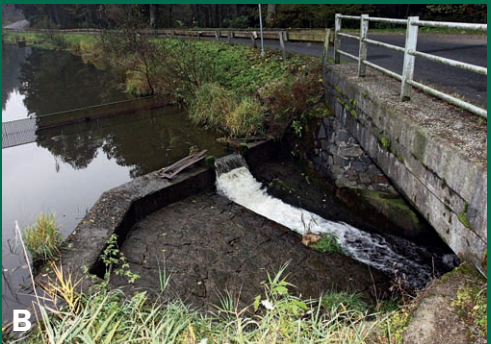
3. Vhodné řešení. Bezpečnostní přepad s výškovým stupněm do 20 cm je pro vydra průchozí
