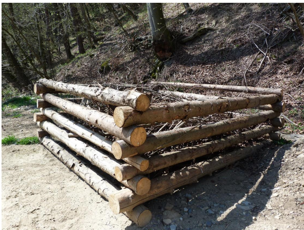
Obr. 12: Hrubá stavba líhniště v lokalitě Sv. Štěpán – most v Bílých Karpatech. Foto Mojmír Vlašín
