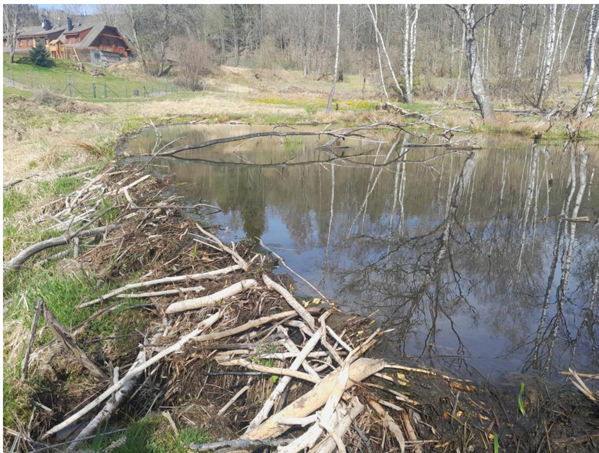
Obr. 14: mokřad 3 - zdrž (č.2) pohled od levého zavázání hráze k zahradám
