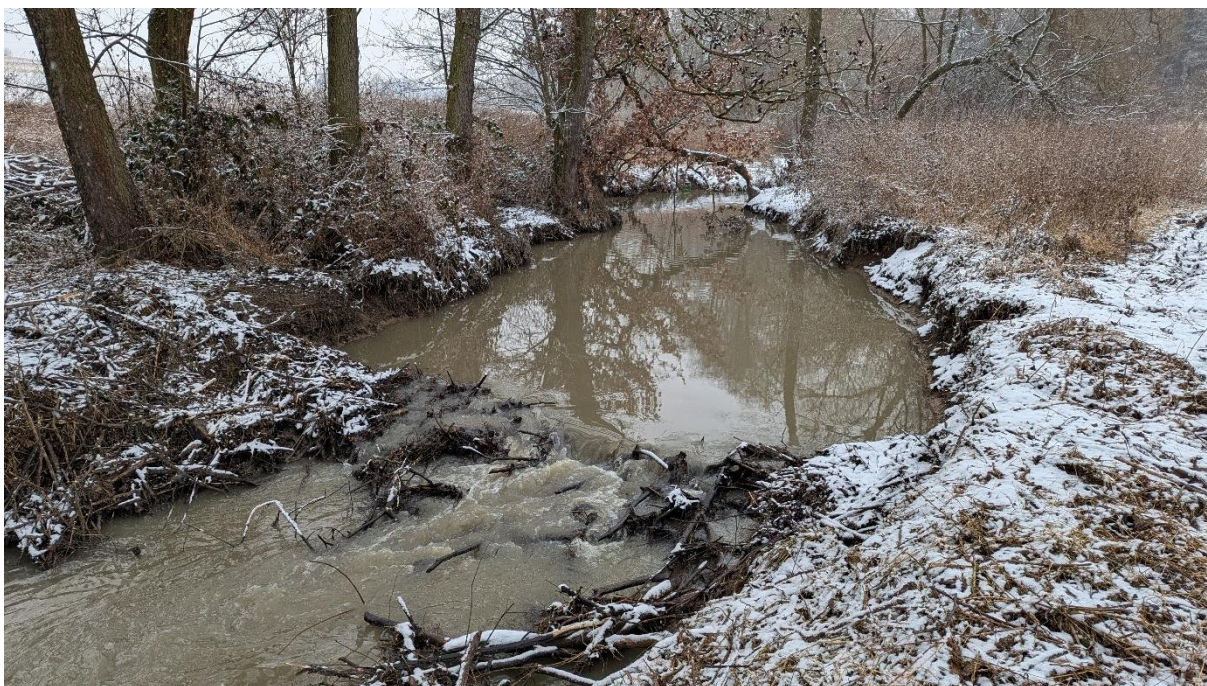
Obr. 54: hráz 6b výrazně snížená (foto 12.2.2025)
