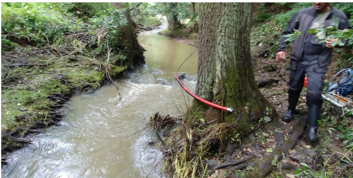
Obr. 49: fotografie poškozené instalace na dolním profilu po povodni 27.6.2024
