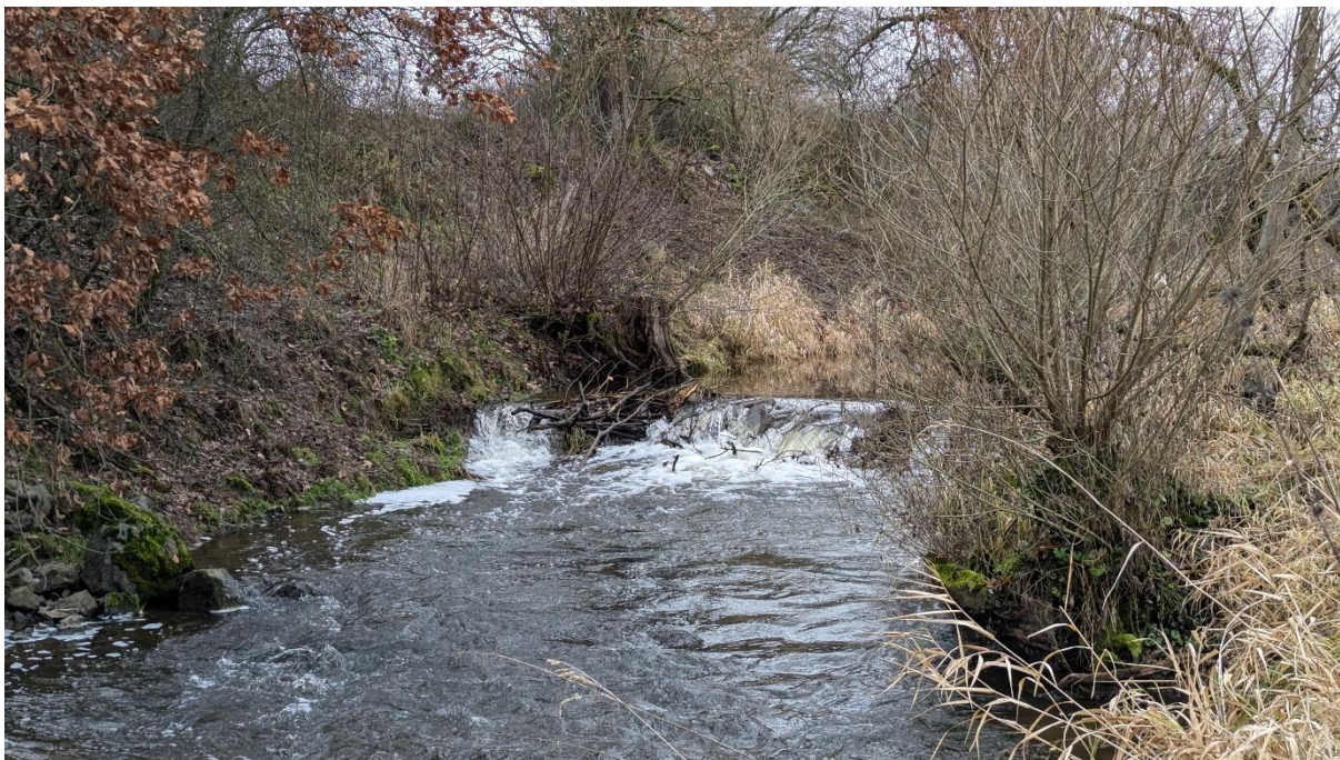
Obr. 75: obnovená hráz č. 1 na podzim 2024
